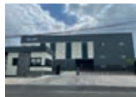
НЖС ВЬЕТНАМ (ЗАВОД 2)
